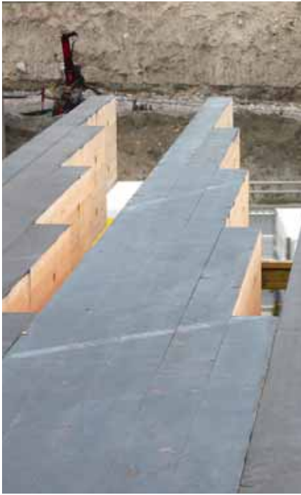
Osa liimapuupalkkeista tehdystä silta- materiaalista.
